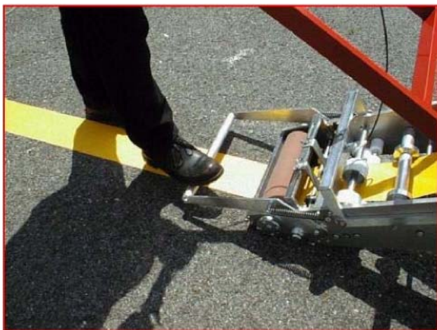
Figura 10: Cómo cortar la cinta
